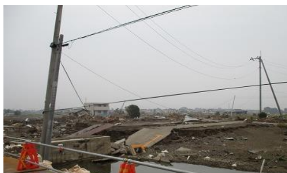
写真 1. 鬼怒川の堤防決壊周辺地域の状況 (撮影：平成 27 年 10 月 11 日時点)
