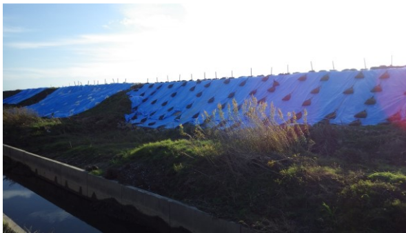
渋井川堤防の仮復旧後の様子
