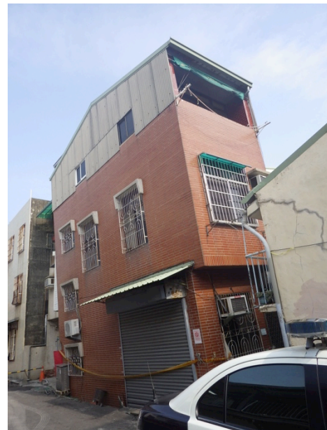
液状化地区で傾いた低層建物
