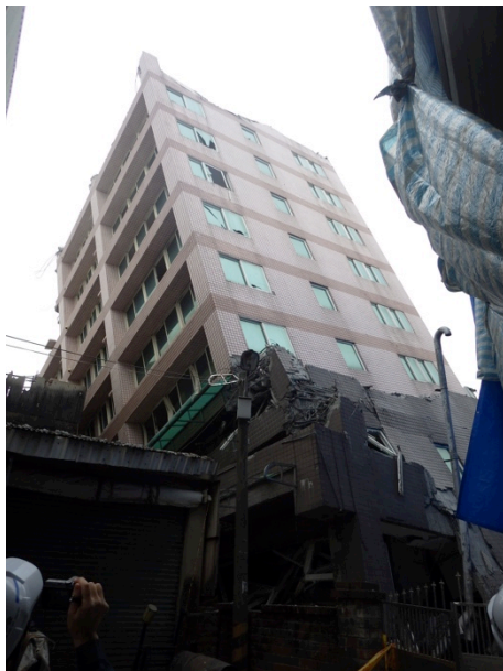
震動被害で傾いた高層建物
