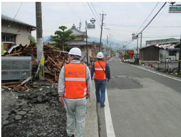
建物被害の調査（益城町）
