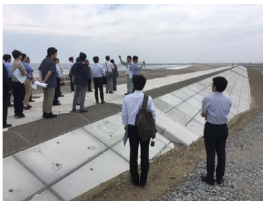
海岸堤防見学の様子
