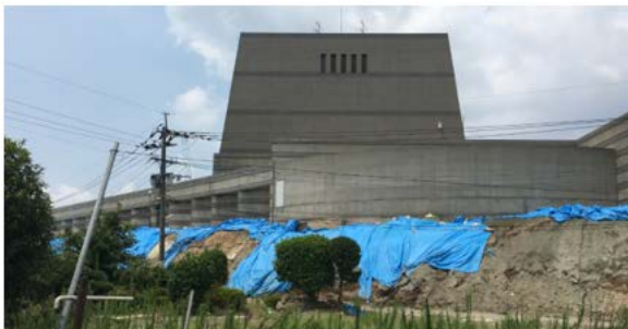
益城町文化会館の被害様子
