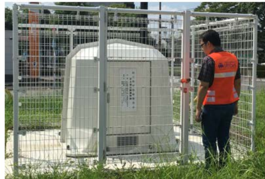
旧宇土市役所内にある強度観測施設
