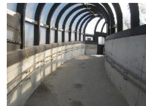
スロープ式津波避難路
