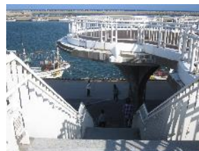
青苗漁港人工地盤
