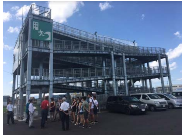
仙台市津波避難タワー視察の様子
