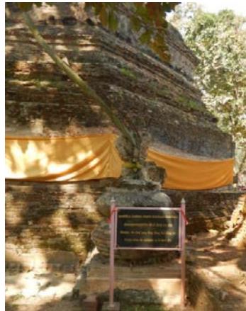
転落した元々の上の部分
