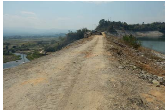
修理中のダム
