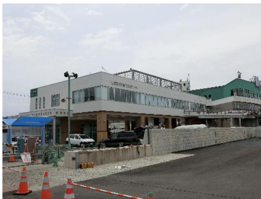
塩竈市津波防災センター
