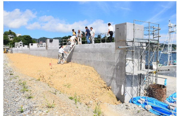
魚町地区の膨張(フラップゲート)
