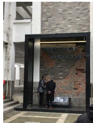
四川大地震で被災し耐震補強された小学校
