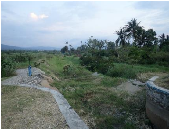
コンクリート護岸が整備されていない灌漑用水が液状化をもたらした可能性も, Jono Oge
