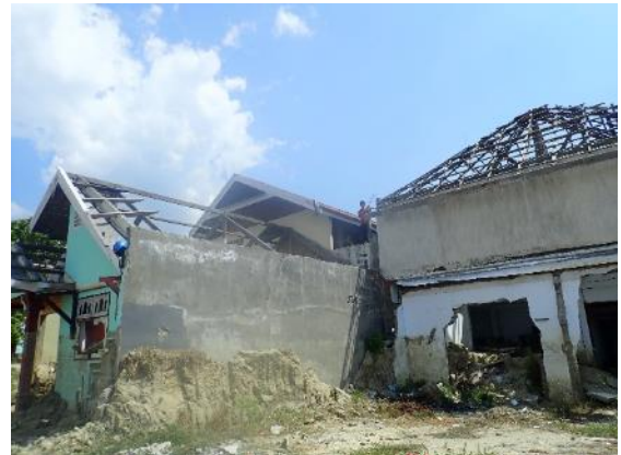
液状化で発生した泥流が住宅を破壊, Petobo
