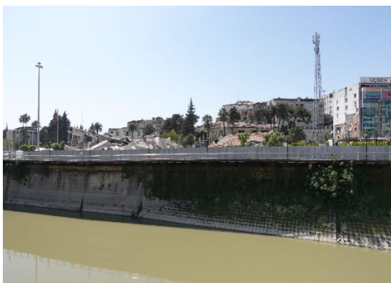
アンタキヤ中心部の石造り歴史建造物の倒壊
