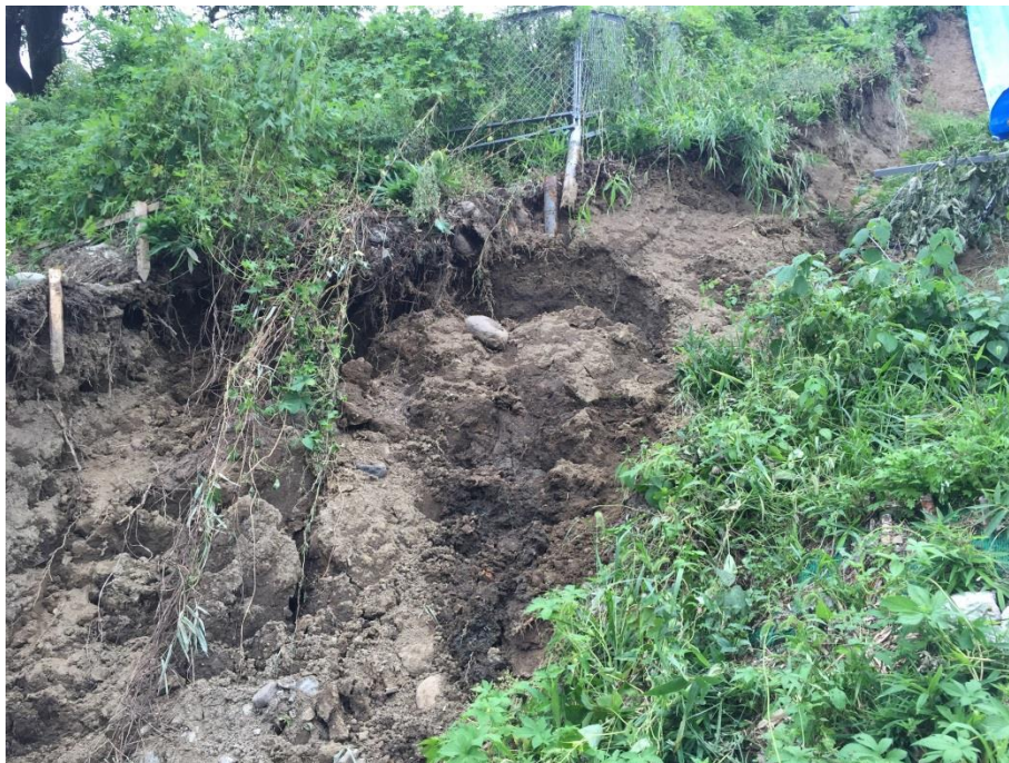
図 9 崩壊部分側面の土の様子
