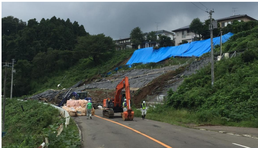
図 6 崩壊後の土砂流出の様子（2015 年 9 月 13 日撮影）
