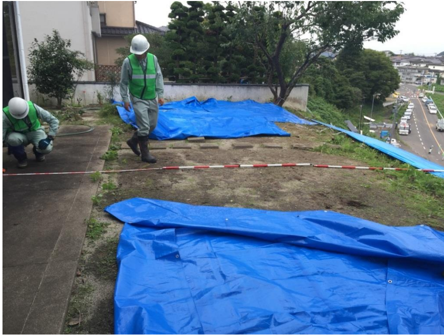
図 10 崩壊部分上部の民家の庭（滑落崖から民家までの距離が 6m 程度）
