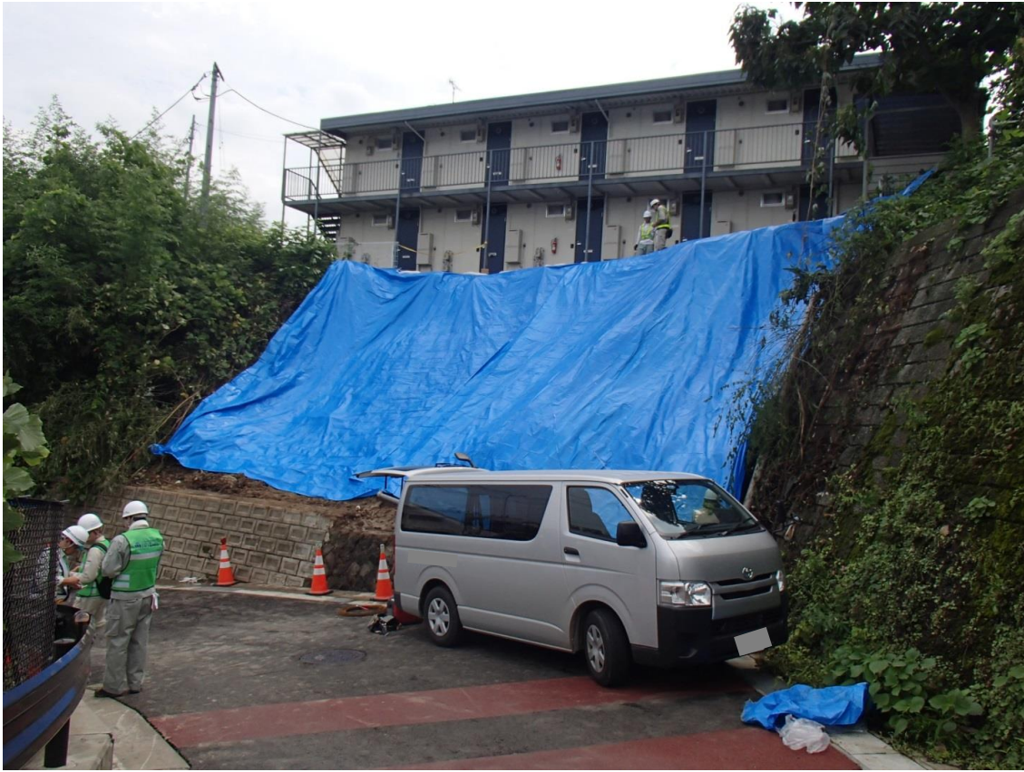
図5 応急対策中の様子 (2015年9月13日撮影)
