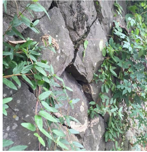
図 16 石積み擁壁のズレ
