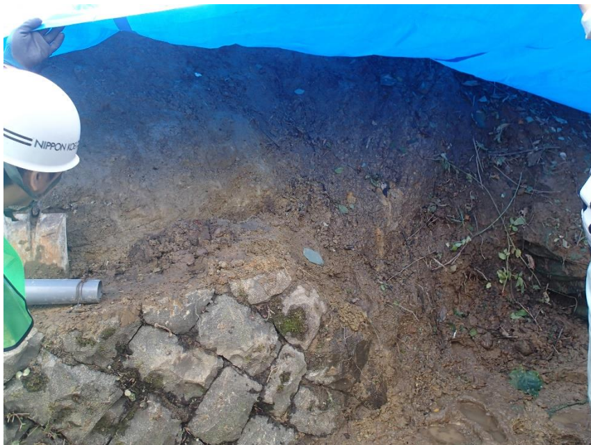
図 11 崩壊部表面の様子
