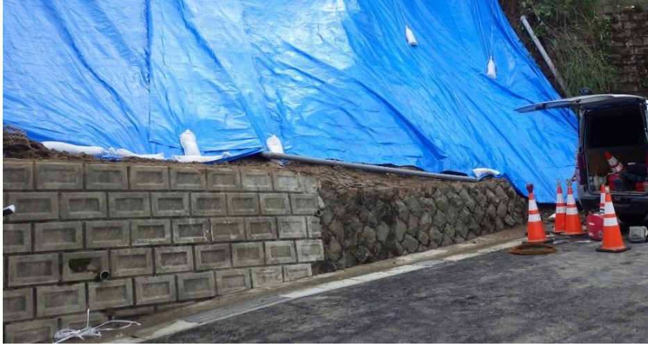
図7 斜面下部の擁壁
