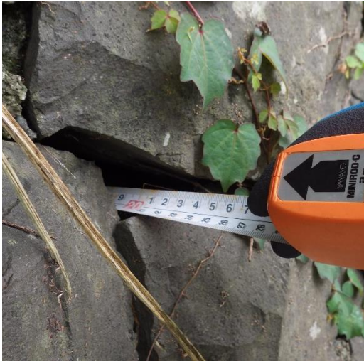
図 15 石積み擁壁の開口部
