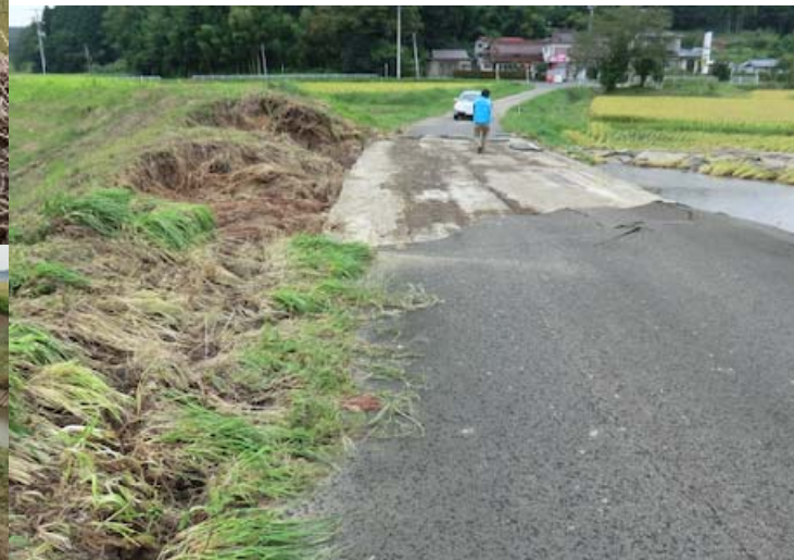
大和町付近での被害状況 (越流と浸食)
