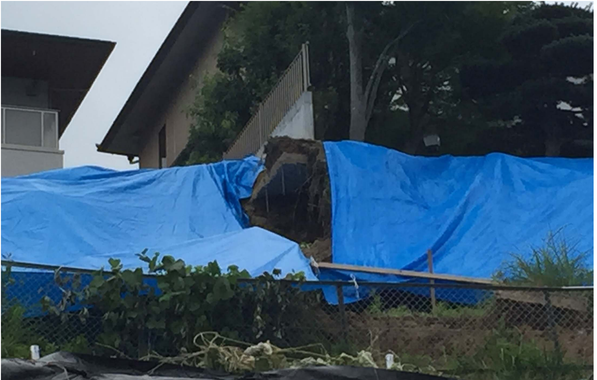
滑落崖(すべり面上部)が民家の敷地内を通る 建物から滑落崖までの距離は約6m程度
