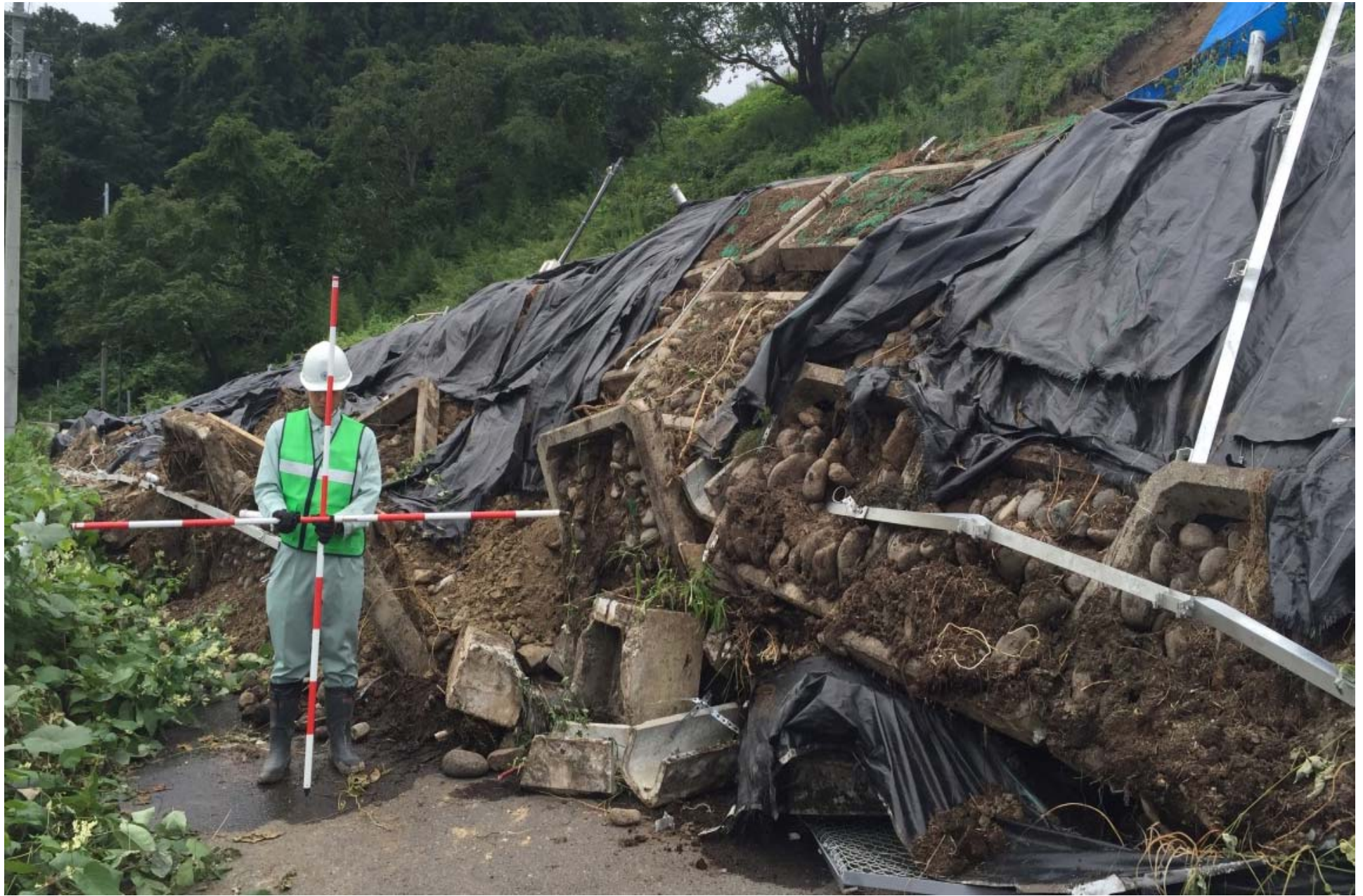
流出土砂の先端部の堆積厚さは約3m 段切り、排水工、コンクリート枠にぐり石と植生土のうを詰めた対策工の形跡あり
