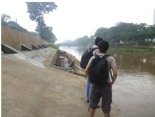
2013年1月洪水で破堤した堤防の復旧状況
