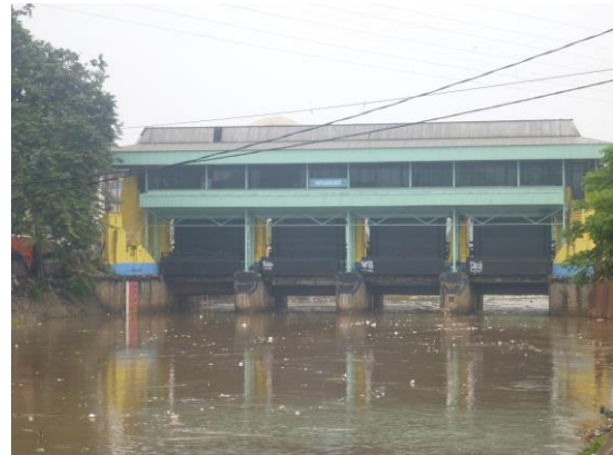
カレット水門（西排水路）（ゴミの堆積無し）
