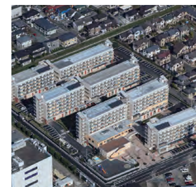
市内初の災害公営住宅。屋上に避難できます。
