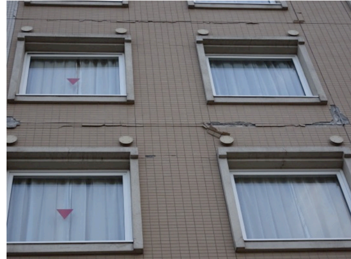
翌朝の壁面(タイルの剥離による落下)
