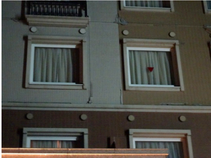
本震直後の壁面(タイルの剥離による落下)
