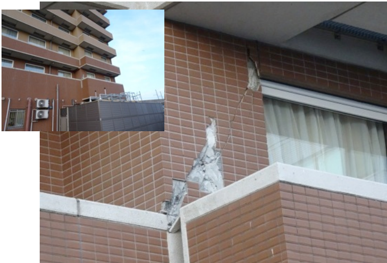
ホテル裏側の柱のせん断破壊
