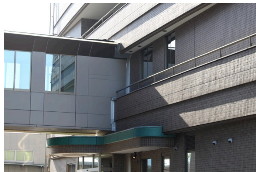
エキスパンションジョイントの被害が見られなかった
