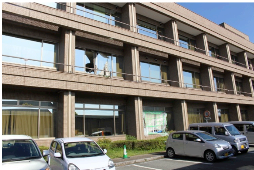
宇城市役所建物裏手のガラス面が飛散
