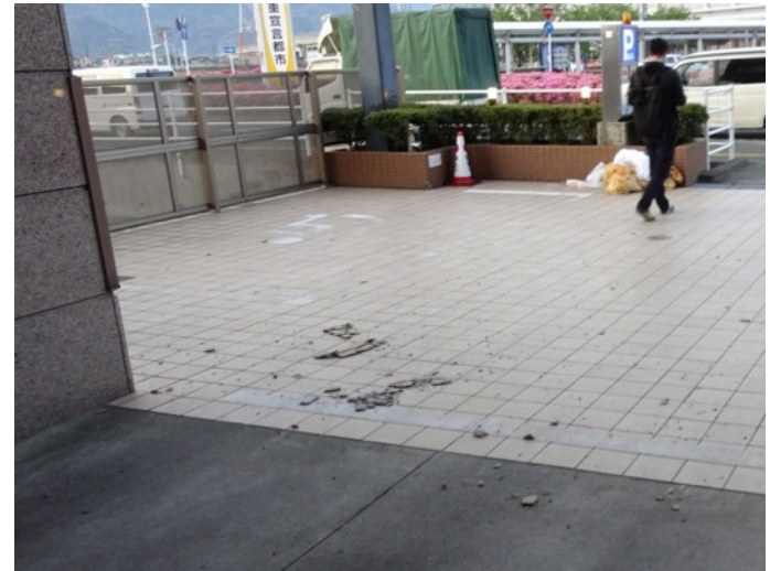
エントランス部分にタイルの落下(怪我人無し)
