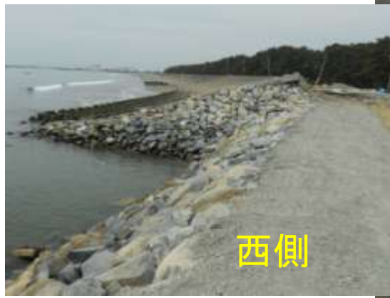
堤防背面の洗掘 (目測で奥行き50m, 深さ2m程度)
