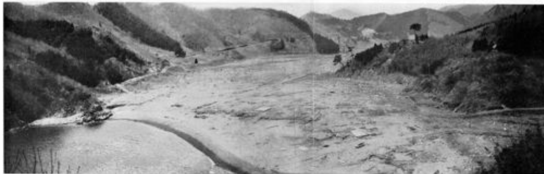
第 288 回 本郷（唐丹） 全部は文字通りの全滅で全く荒野と化した。（4 月 30 日 石本撮影） Fig. 288. Panoramic view of Borgō (Tōnō). Village completely demolished. (Photo by M. Ishimoto, April 30.)
