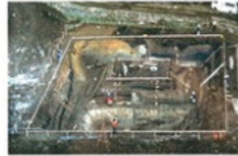
図2. 活断層のトレンチ掘削風景
