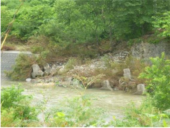
土砂崩れに伴う堤防の破損状況（西川町）
