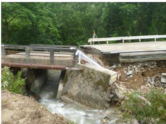
基礎地盤の洗掘に伴い陥没した道路橋（西川町）
