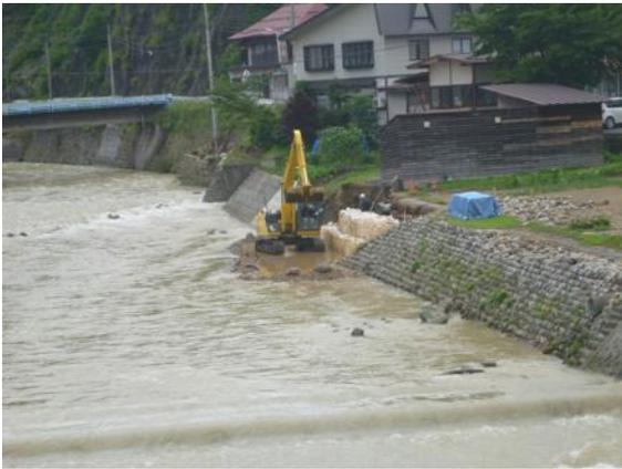
堤防の浸食箇所を土嚢で応急処置する様子（大江町）
