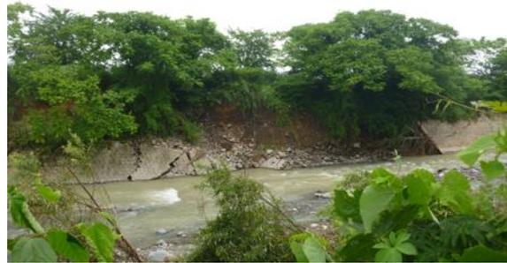
土砂崩れに伴う堤防の破損状況（鶴岡市）
