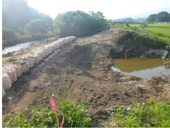
引欠川の破堤を土嚢で応急対応する様子（秋田県大館市）
