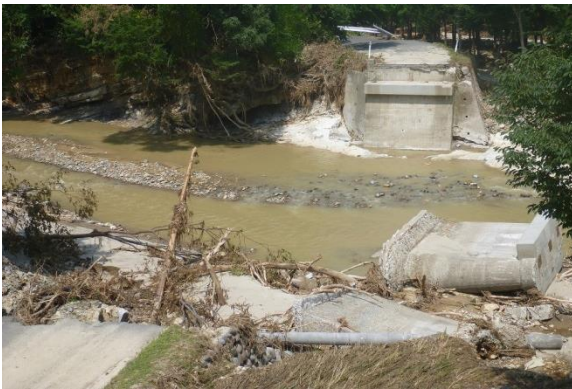
洪水により破壊された矢櫃橋（岩手県雫石町）
