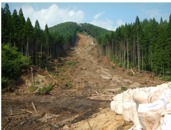
大規模な斜面崩壊が発生した斜面（秋田県仙北市）
