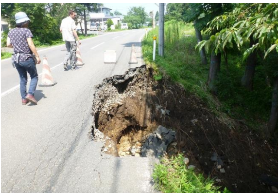
雨水流出による道路浸食の様子（岩手県雫石町）
