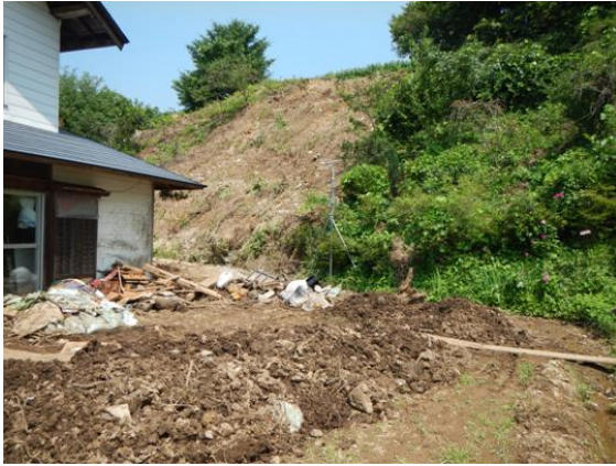
民家裏の斜面崩壊（岩手県花巻市）
