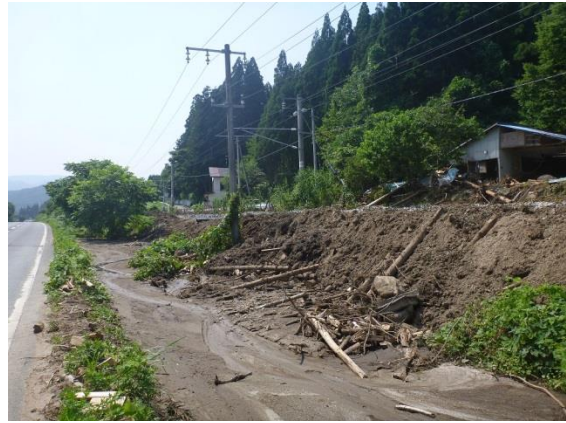
田沢湖線（秋田新幹線）での土砂崩れ（岩手県雫石町）
