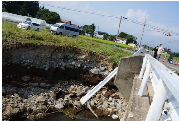
河川湾曲部の洗掘の様子（岩手県雫石町）
