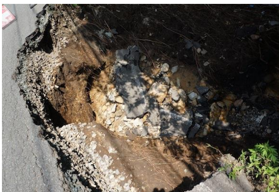
火山性堆積物および河川堆積物の崩落（岩手県雫石町）
