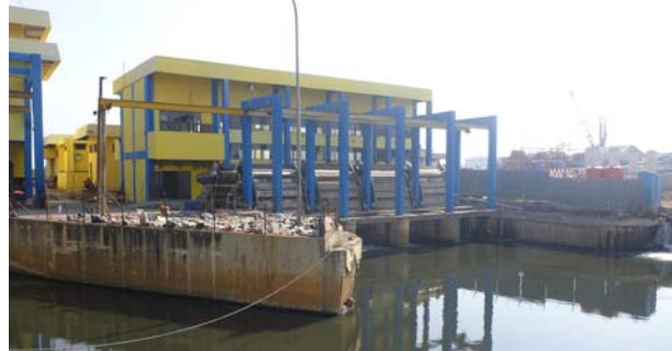
視察したブレイットポンプ場（中央排水機場）
