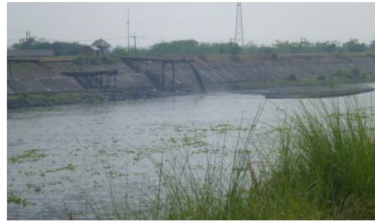
ポロン川への汚泥の流入状況(2013/11/13)
