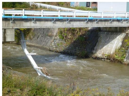
洪水流が橋桁を越水しガードレールが破損
