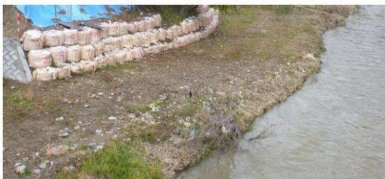
堤防の浸食箇所を土嚢で応急保護する様子
