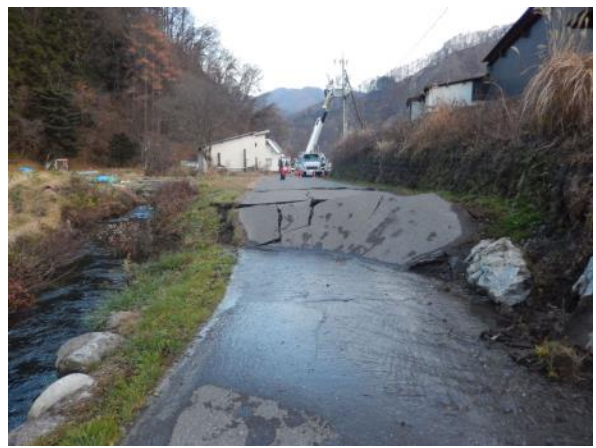
現地調査の様子（2）
