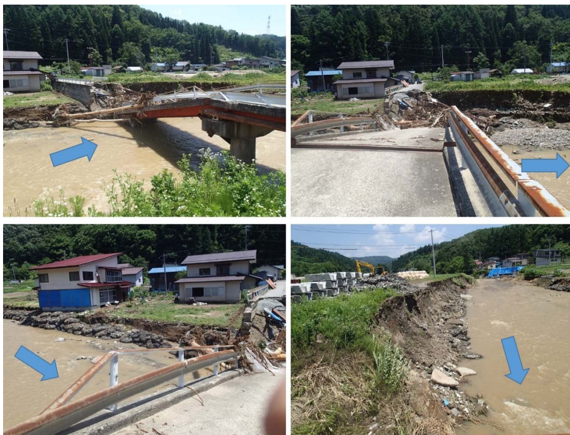
図-36 吉野川金山地区白在家橋の被害状況。
