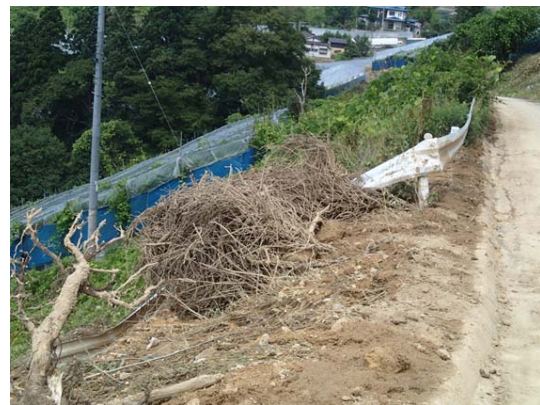
図-9 変形したガードレール.
