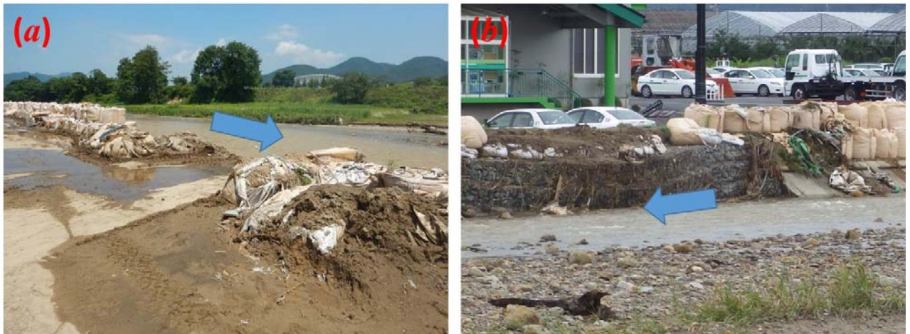
図-34 赤湯自動車学校堤防上の盛土の侵食，土嚢の流出状況（2014年7月12日撮影）。
