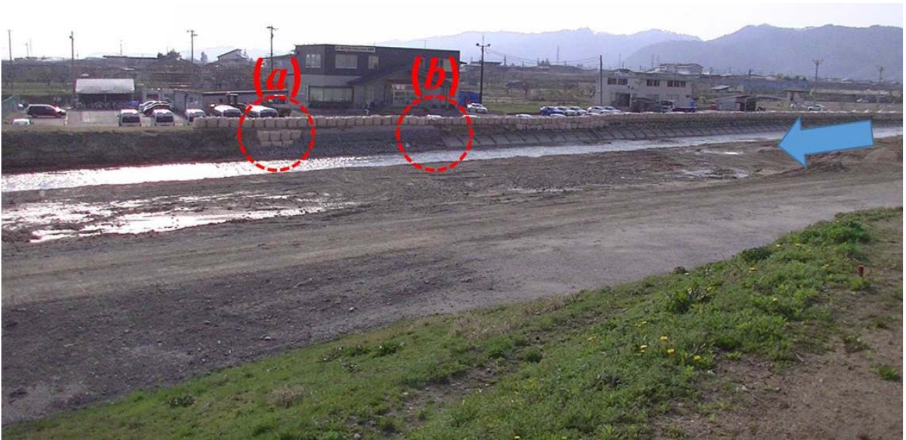
図-33 赤湯自動車学校堤防の土嚢での対応状況（2014年4月26日小森准教授撮影）。
