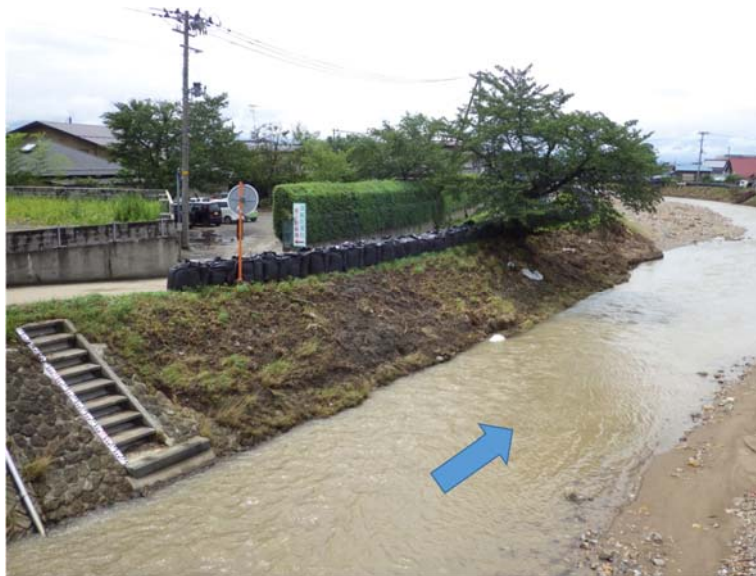
図-25 吉野川花見橋地点（図-6 中②地点）直下流の越流箇所.
