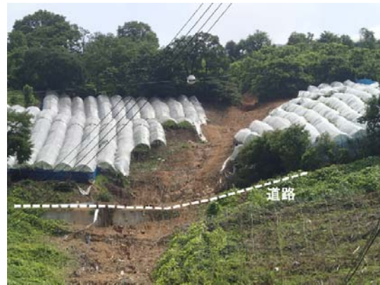
図-7 斜面上部の崩壊部分.
