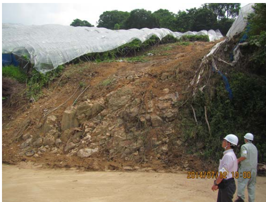
図-8 斜面中腹の道路から斜面上部を撮影.
