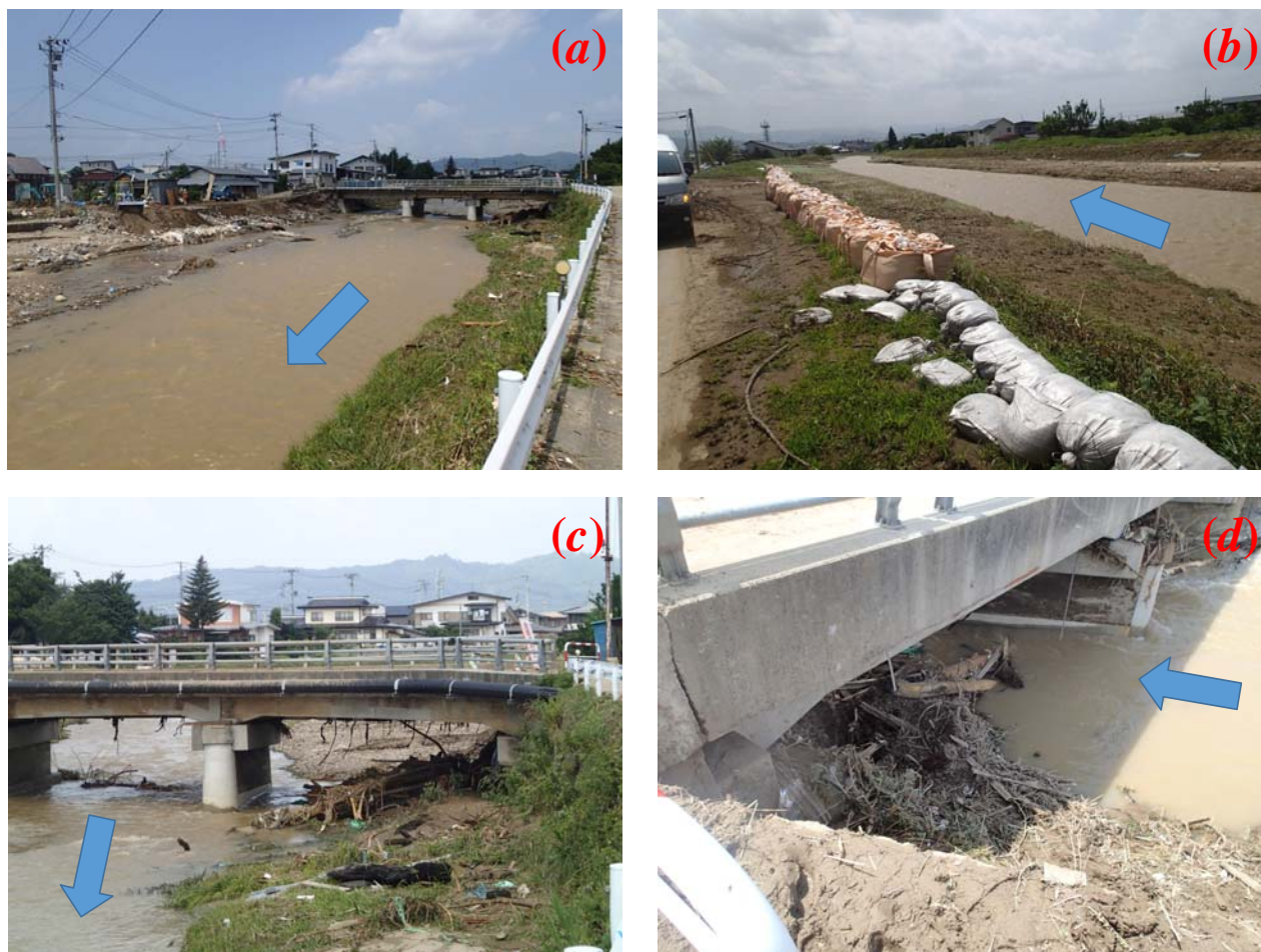
図-24 吉野川吉野橋地点（図-23 中①地点）の被害状況。
