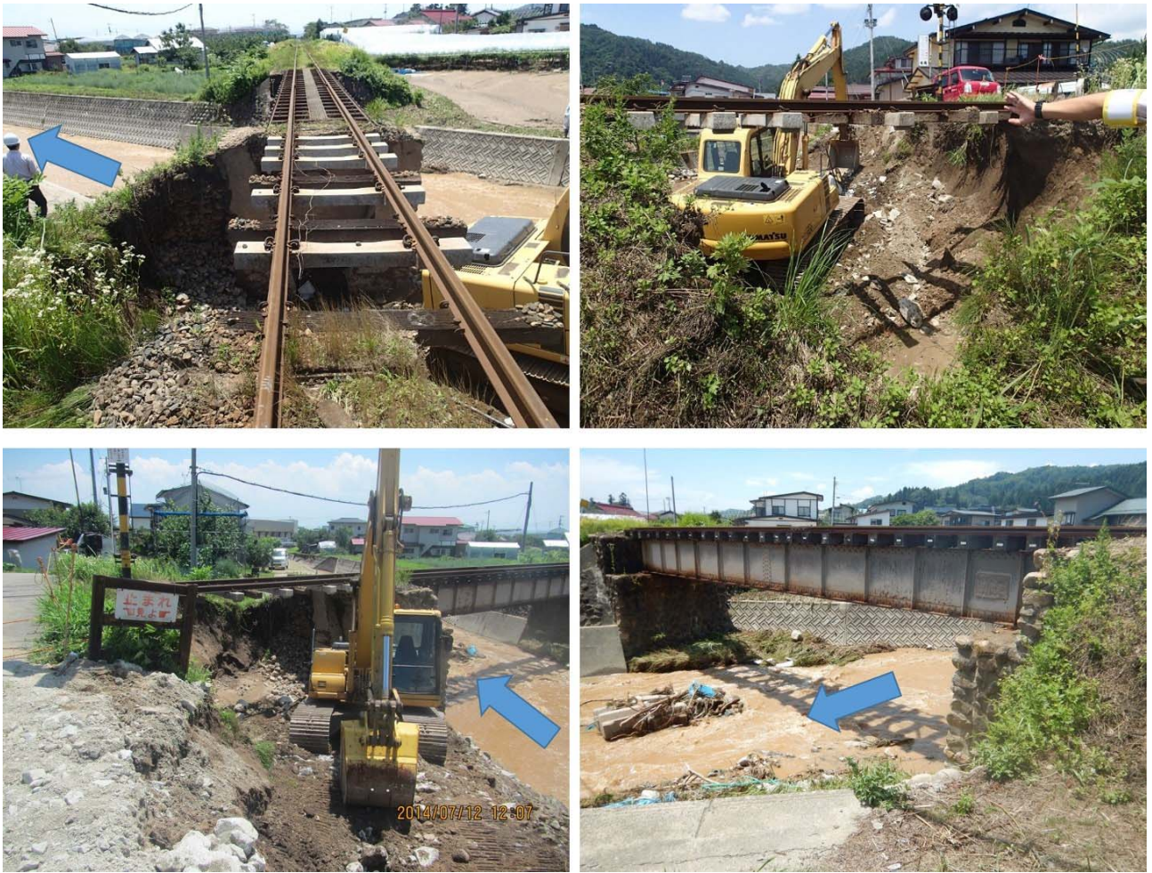
図-37 織機川にかかるフラワー長井線の被害状況.
