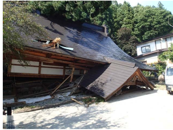
図-16 土砂に押し潰された建物.
