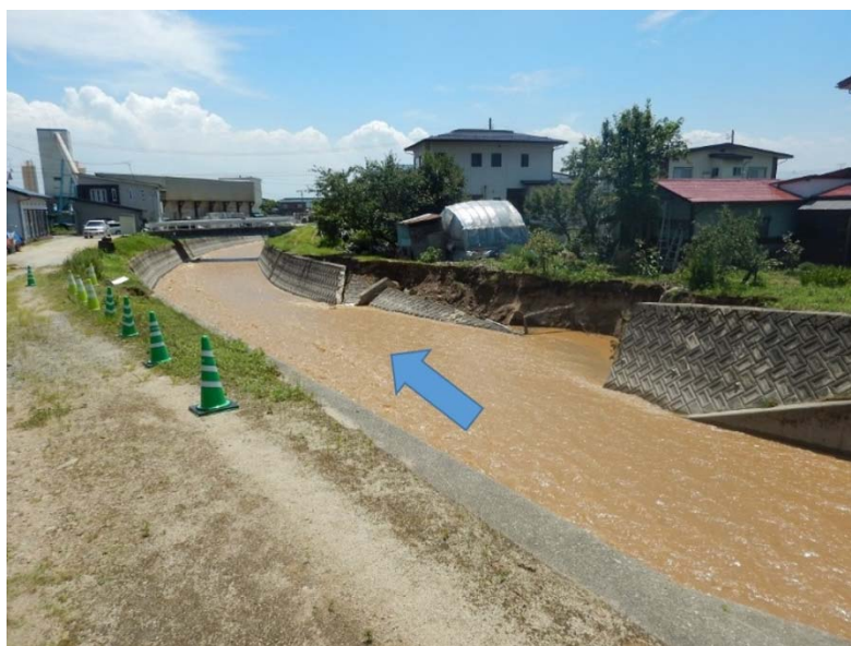
図-38 織機川における護岸崩壊の状況.
