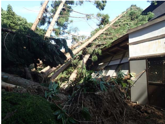
図-17 建物背面に押し寄せる土砂.
