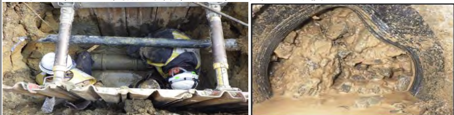
部分補修の状況写真
