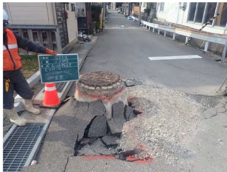
【埋戻し部の人孔浮上状況写真】
