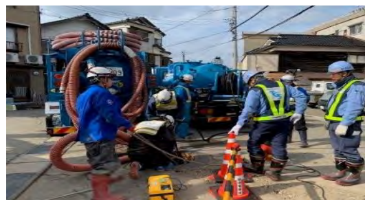
応急復旧、二次調査状況
