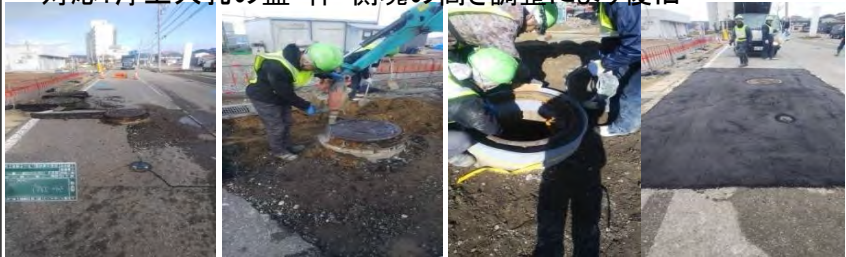
浮上人孔の復旧状況写真
