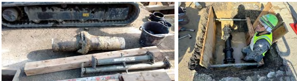
圧送管の復旧状況写真
