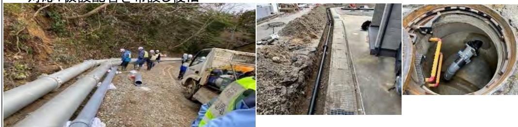
地上仮設配管(φ200・210m)の状況写真
