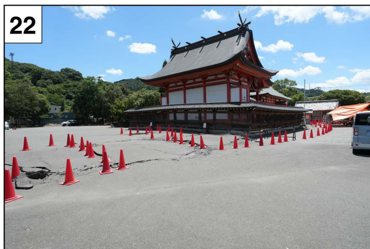
22 八代神社の社殿を横切る地震断層。西側の低下により社殿が撓む。7 月 31 日遠田撮影。
