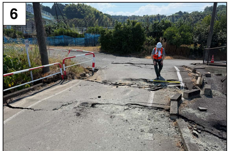
氷川町道の駅「竜北」の約500m南方で道路を顕著に右横ずれさせる地震断層。白線や道路脇のブロックが175cm右横ずれしている。8月3日遠田撮影。
