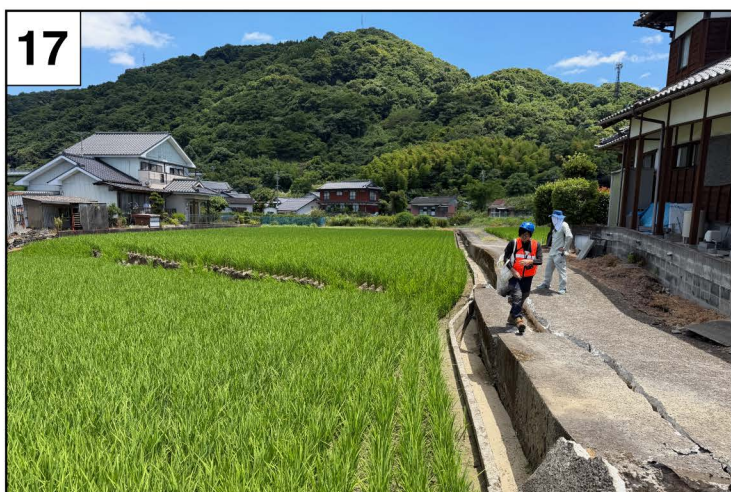
八代市宮地町の水田を横切る地震断層。右横ずれ変位量 105 cm。東側隆起の上下変位量 90 cm。7月31日遠田撮影。
