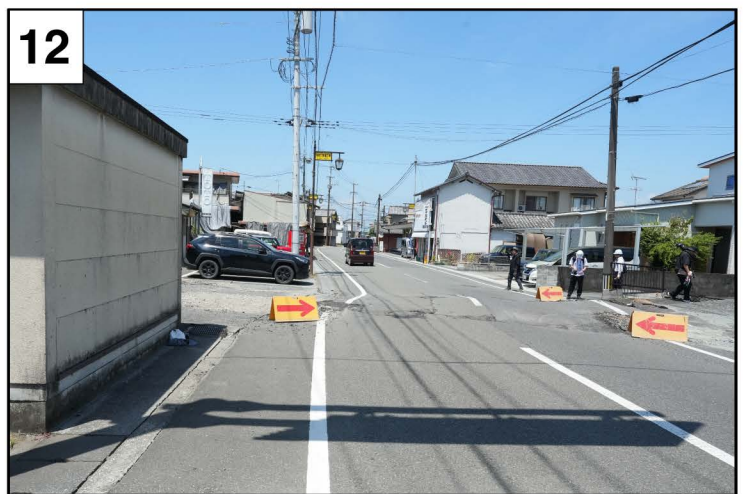
12 国道443号線を横切る地震断層。右横ずれ140cm。氷川町宮原栄久。→の部分断層が横切り、断層帯部分が若干隆起。8月1日遠田撮影。
