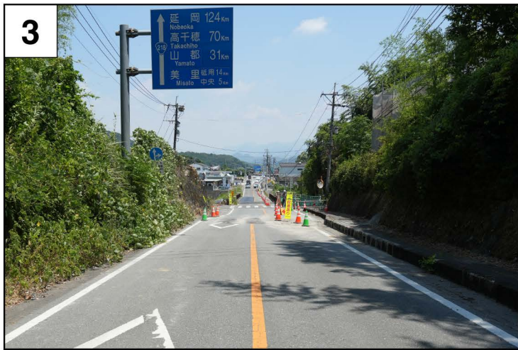
宇城市豊野町山崎の国道218号線を横切る地震断層。右横ずれ135cm。8月2日遠田撮影。
