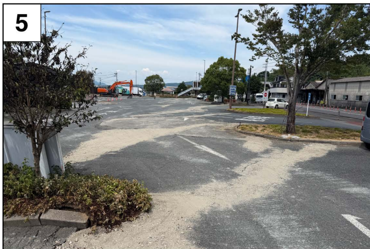
氷川町道の駅「竜北」の駐車場を縦断する地震断層。杉型雁行配列が顕著。地震直後に砂が充填されている。8月1日遠田撮影。
