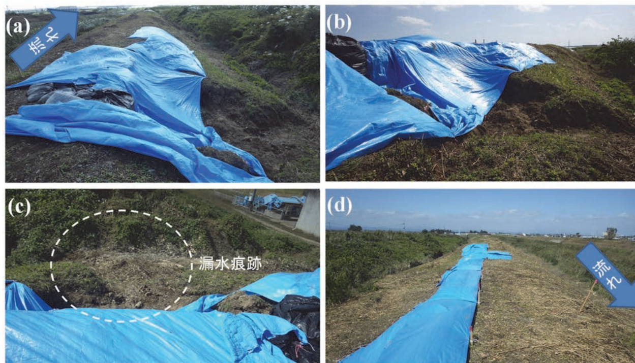
図-15 渋井川右岸側の状況
