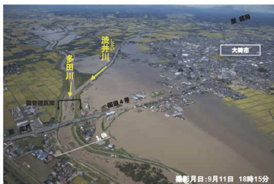
▲ 鳴瀬川水系多田川3.0km付近より渋井川合流部を撮影
