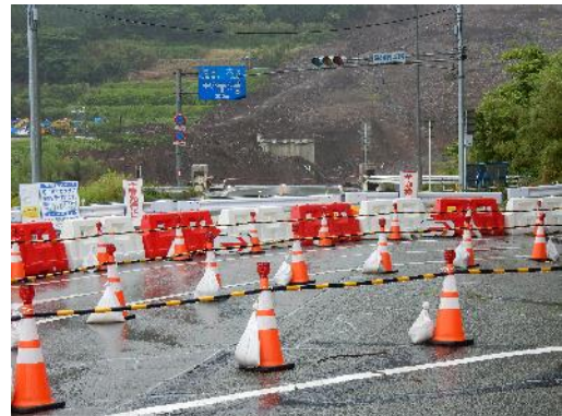
阿蘇大橋崩落箇所
