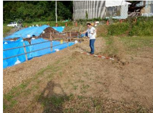
地表地震断層箇所の調査（益城町）
