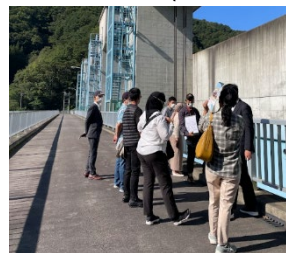
Flood gate (Fudai)
