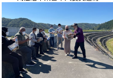
宮古市田老地区の防潮堤
