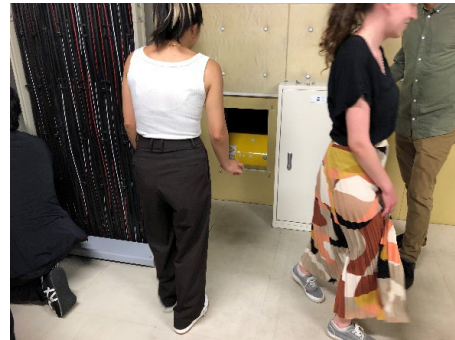
制振装置見学（赤坂インターシティ AIR）
