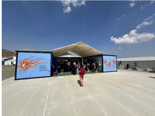
仮設の心理社会支援センターの外観
