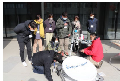
VSATのパラボリアンテナを 人工衛星を指向し調整する
