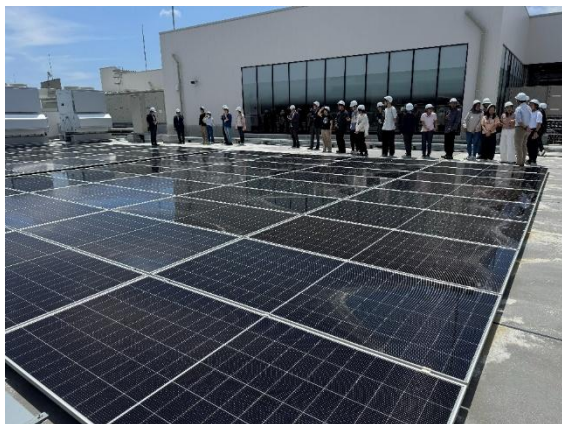
屋上の太陽光発電設備の視察
