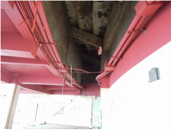
タクロバンコンベンションセンター内店舗の 天井空間
