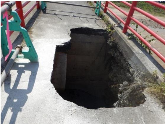
雨水流出により陥没した橋
