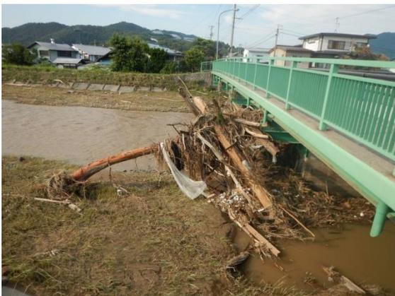
吉野川橋桁下部に堆積する流木の様子
