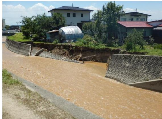
洪水流による織機川の護岸侵食の様子
