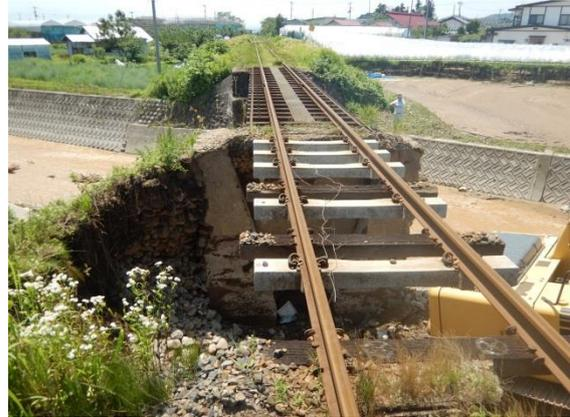
洪水流により土台が洗掘されたフラワー長井線
