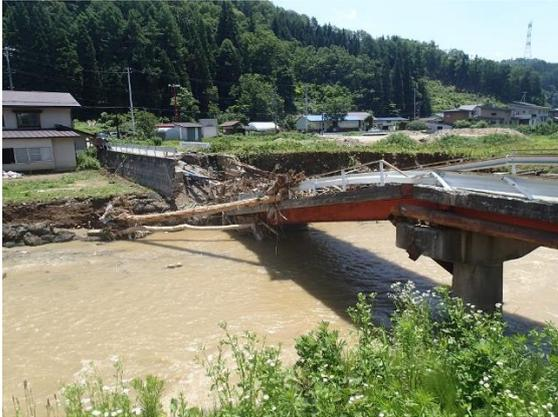
洪水流の洗掘により崩落した吉野川の白山在家橋
