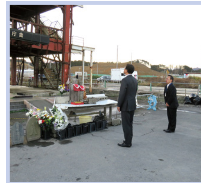
チリ地震津波を受けて建造した12mの防災対策庁舎を上回る15.5m津波が到来しました。アンテナにしがみついたり、階段に引っかかったりした町長ら11名を除き、43人が犠牲になりました。震災遺構として原爆ドームと同様の価値があることから、2031年まで宮城県が一時県有化して保存することが決まっています。
