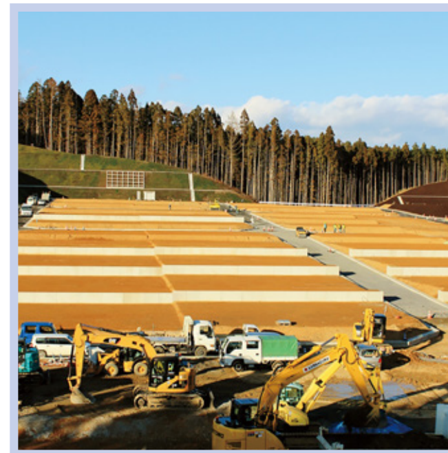
甚大な被害を受けた南三陸町伊里前地区にて、造成が進む防災集団移転宅地（2016年1月現在）。同年3月の引渡しを受け、被害者個人による戸建て住宅の再建が始まります。
