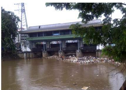
（写真4）カレット水門に堆積したゴミ（Deltares提供写真）。流域に居住する住民の3割が、ごみ収集所が遠いなどの理由から、日常的にゴミを河川に投棄しており、深刻な社会問題となっている。
