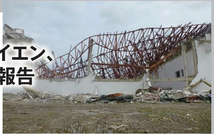
(写真1)強風により屋根が崩落した避難施設のレイテ・コンベンションセンター
