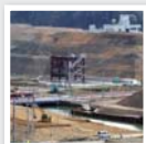
南三陸町防災対策庁舎
