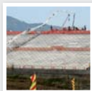
工事中の第二線堤
