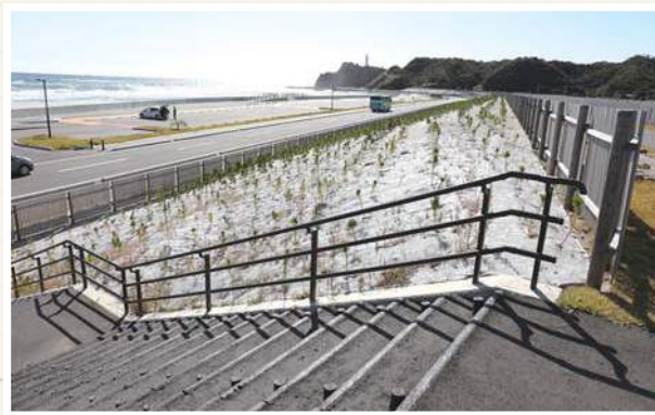
薄磯地区の海岸沿いに整備された防災緑地。松の苗が植えられたばかり
