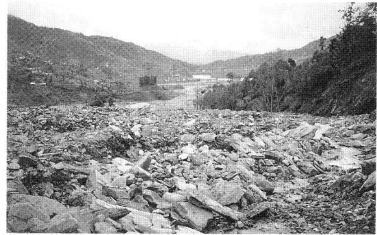
写真-5 パルン周辺の土石流災害
