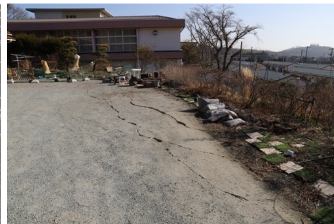
盛土箇所の地割れ ※住民談
