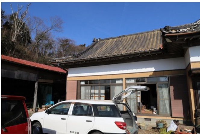
棟瓦落下による車輛破損 ※住民談(東日本大震災で補修したが今回の地震でも落下)
