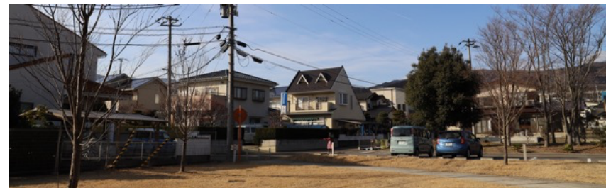
一見して被害がみられず(役場裏側)
