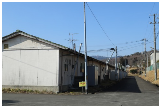
観測点近くの建物 (外観からは無被害)
